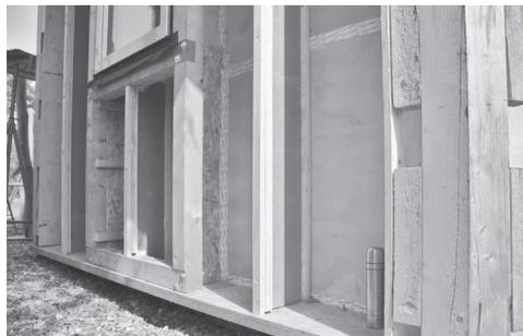
Bildung der einzelnen Kammern für das Dämmmaterial
