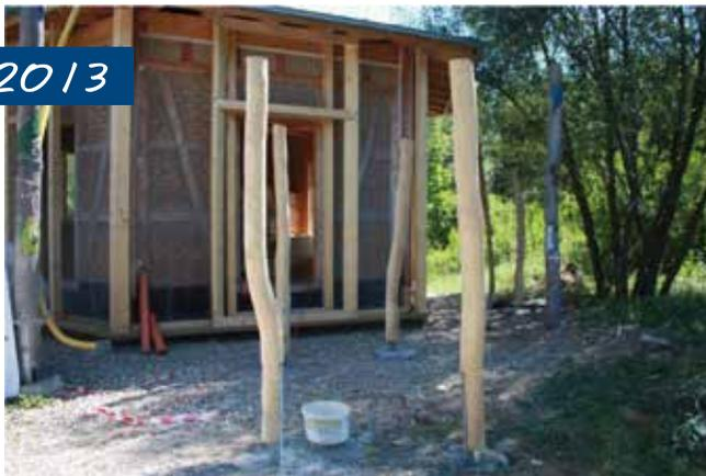
Neben zahlreichen anderen Arbeiten wurden 2013 die Robinienstämme abgeschliffen, ausgerichtet, „beschuh“ und einbetoniert
