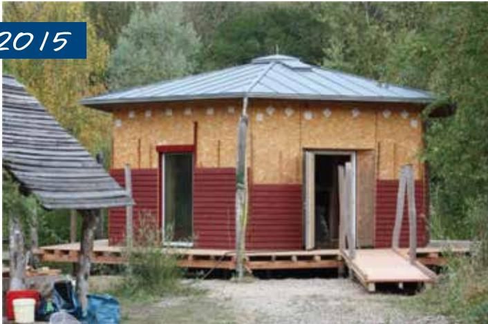
2015 wurden die Bretter gestrichen und am unteren Teil des Hauses rundherum angebracht, damit anschließend die Veranda und die Rampe (incl. der jeweiligen Unterkonstruktionen) gebaut werden konnte.
