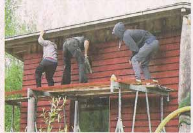
Die Jugendlichen beim Arbeiten am Rohbau
