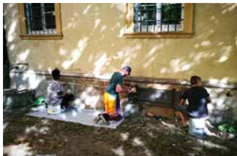
Abklopfen Steine und Öffnen der Fugen
