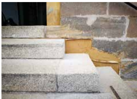
Ausgeklopfte Fugen
