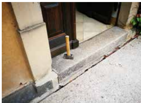
Ausklopfen der Treppenfuge
