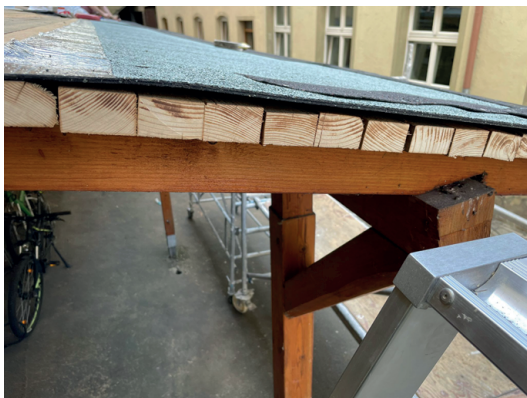
Abb. 14: Regenfestes Dach des Unterstandes
