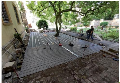
Abb. 10+11: Bau der Unterkonstruktion und Bretterung mit WPC-Dielen
