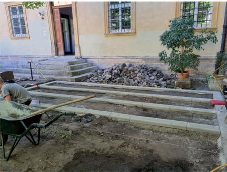
Abb. 6: Setzen der Tiefbord-Rabattensteine
