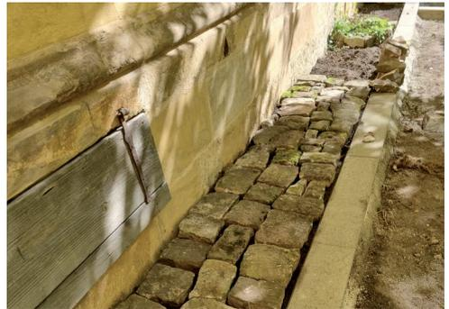
Abb. 7: Setzen der Pflastersteine
