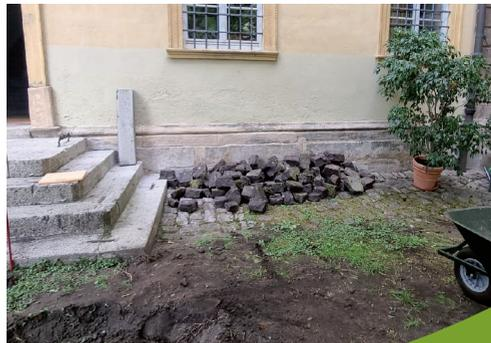
Abb. 3+4: Entfernung der Pflastersteine
